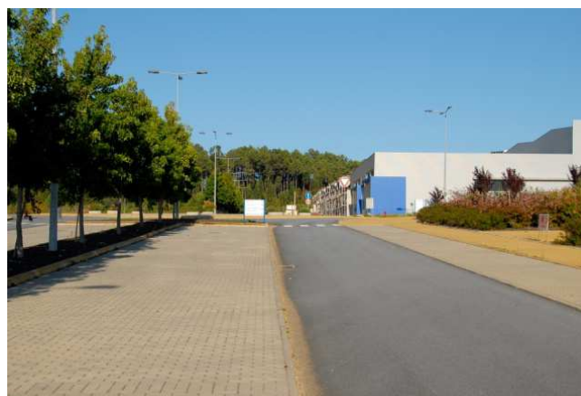
Figura 4.24 - Infra-estruturas do loteamento existente do Parque Empresarial de Lanheses.
