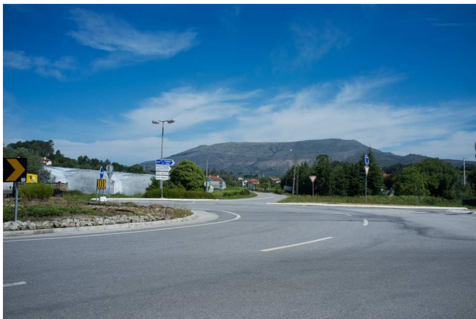
Figura 5.4- Vista a partir do ponto A12, junto à rotunda da EN, para norte.
