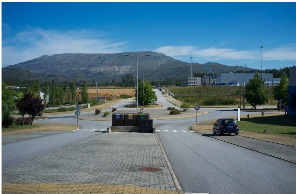
Figura 4.32 – Aspeto da UP3.
